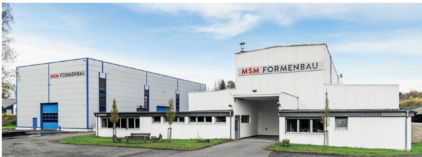
Siedziba firmy MSM Formenbau GmbH w Langenhahn z halami produkcyjnymi i budynkiem biurowym.
