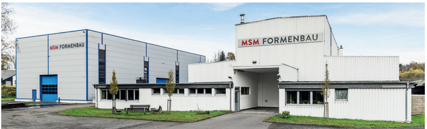
Site de MSM Formenbau GmbH à Langenhahn avec les halls de fabrication et l'immeuble de bureaux
