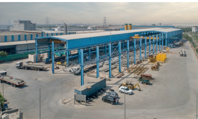
Stellar Precast forma parte de Stellar Group y suministra a sus obras en el NCR desde su planta de fabricación altamente automatizada
