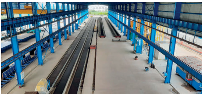
Un total de cuatro líneas con una longitud de 145 metros produce prefabricados de hormigón pretensado en la nueva planta de Steller Precast.
