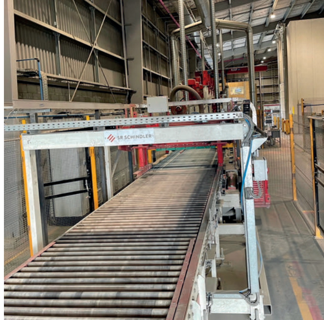
Tuberías del equipo para retirar el polvo
