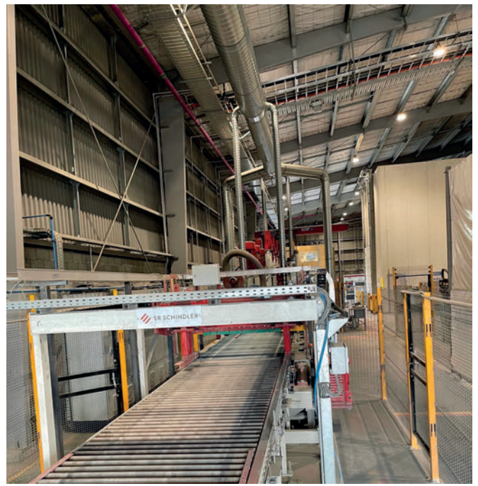
Verrohrung der Entstaubungsanlage
