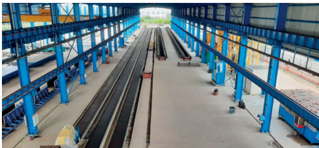
Insgesamt vier Linien mit einer Länge von 145 Metern produzieren in dem neuen Werk von Stellar Precast Spannbetonfertigteile.
