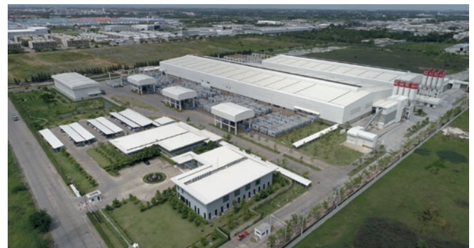
Pruksa była pierwszą i nadal jest wiodącą firmą inwestującą w produkcję prefabrykowanych elementów betonowych w Tajlandii.
