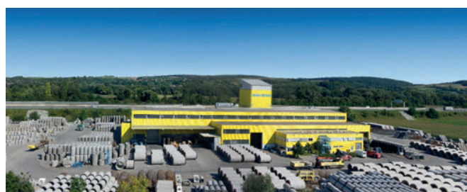
Lo stabilimento Haba-Beton a Nussdorf. Haba-Beton gestisce questo impianto di produzione di tubi e pozzetti vicino Vienna dal 1998.
