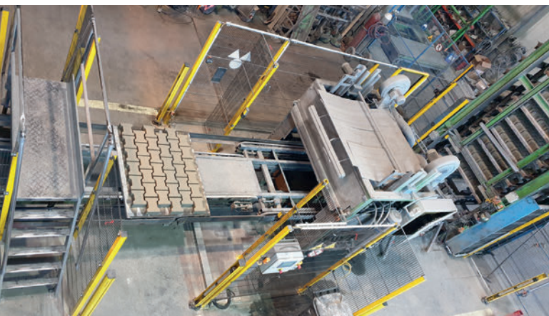
Nuova tecnica di sicurezza sulla linea dell'umido
