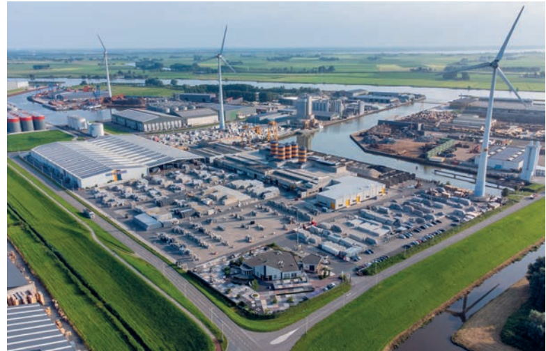
L'usine MBI à Kampen
