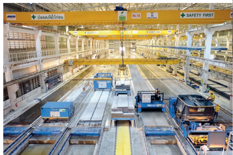
Deux usines ont été équipées de nouvelles machines pour la production de planchers alvéolés en béton précontraint.
