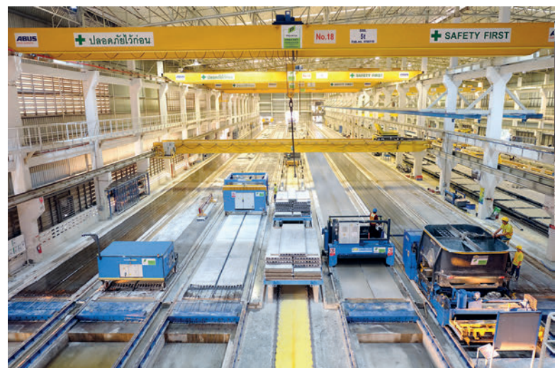
Las dos fábricas han sido equipadas con maquinaria nueva para la producción de placas alveolares pretensadas
