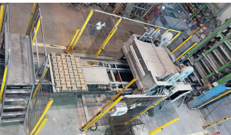
Neue Sicherheitstechnik auf der Nassseite
