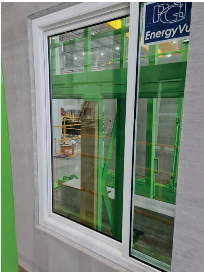
*Komplett einbetonierte Fenster - eine Besonderheit der Anlage*
