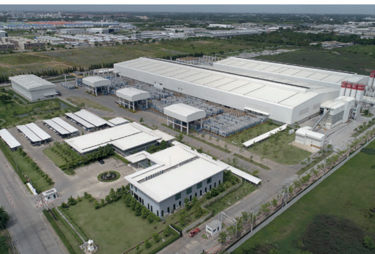
Pruksa war das erste und ist noch immer das führende Unternehmen in Thailand, das in die Produktion von Betonfertigteilen investiert hat.
