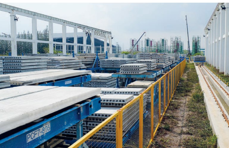
Spannbetonfertigdecken werden für die nachhaltige Errichtung von Wohn- und Gewerbegebäuden verwendet.
