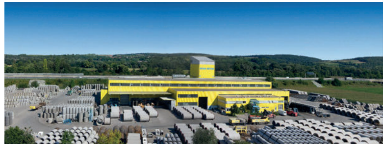
Der Standort Haba-Beton in Nussdorf. Seit 1998 betreibt Haba Beton dieses Werk für Rohr- und Schachtfertigung nahe Wien.
