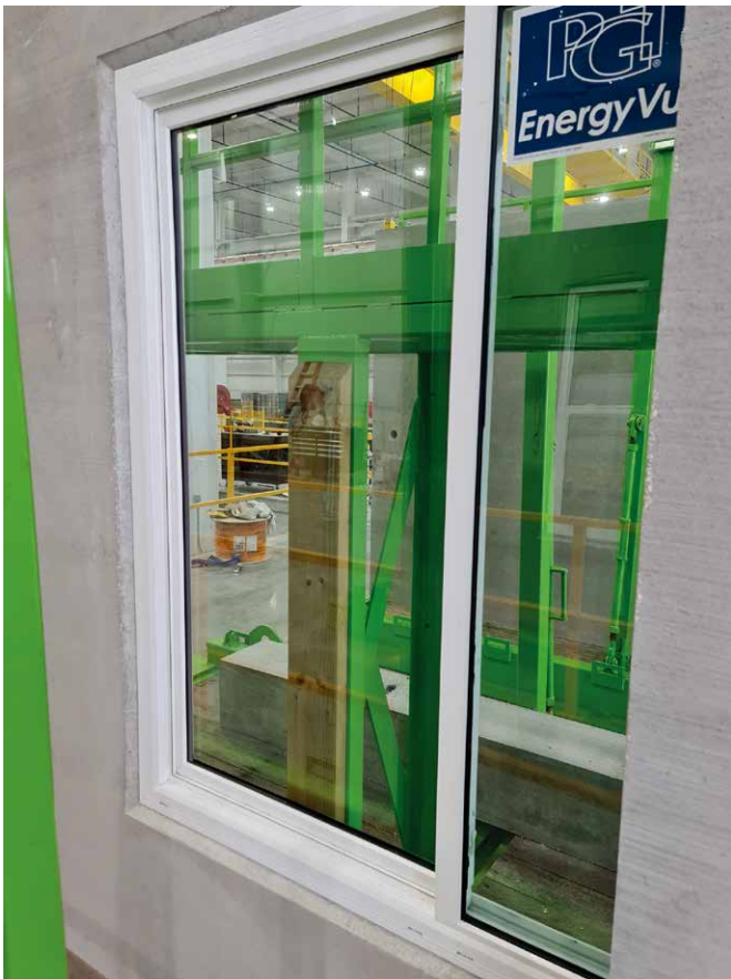
实现完全浇筑的窗户——这是托盘循环工厂的一大特性
