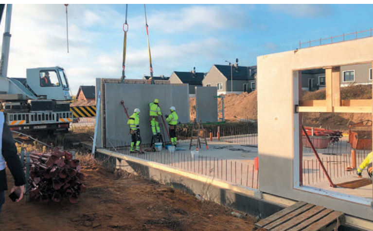
Il rapido montaggio in cantiere avviene con un team professionale e ben formato che sa come gestire i vari elementi prefabbricati in calcestruzzo.
