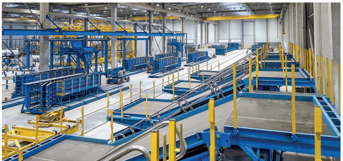
Panoramica di tutto il capannone di produzione per casseri
