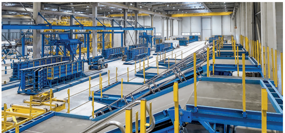
Vista general de toda la nave de producción de moldes
