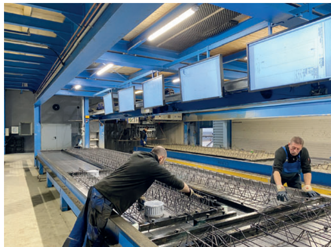
Выходной контроль арматуры
