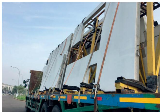
*Gli elementi controllati in funzione della sismicità e antisismici con le riserve già previste per le porte e le finestre vengono trasportati ai cantieri.*
