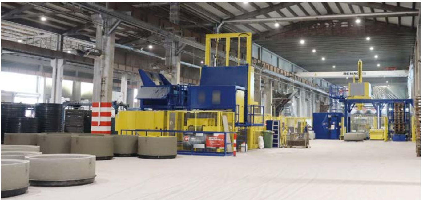
Vue d'ensemble de la nouvelle installation de production Magic
