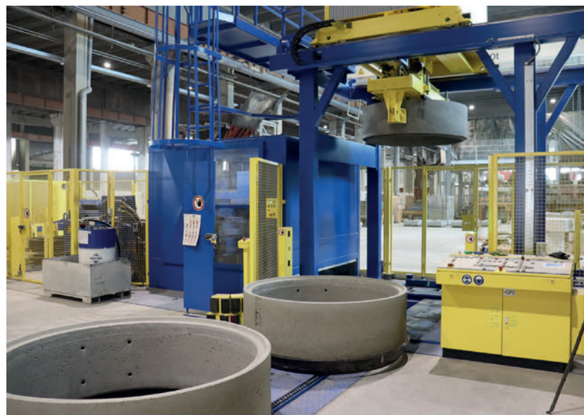
Blick auf die Palettierstation mit angrenzender, blau eingehauster Reinigung und anschließender Muffenölstation
