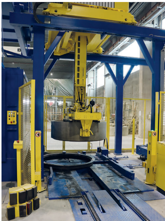
Nachdem der Manipulator das Schachtteil angehoben und damit von der Muffe gelöst hat, wird diese direkt in die Reinigungsstation eingeschoben.
