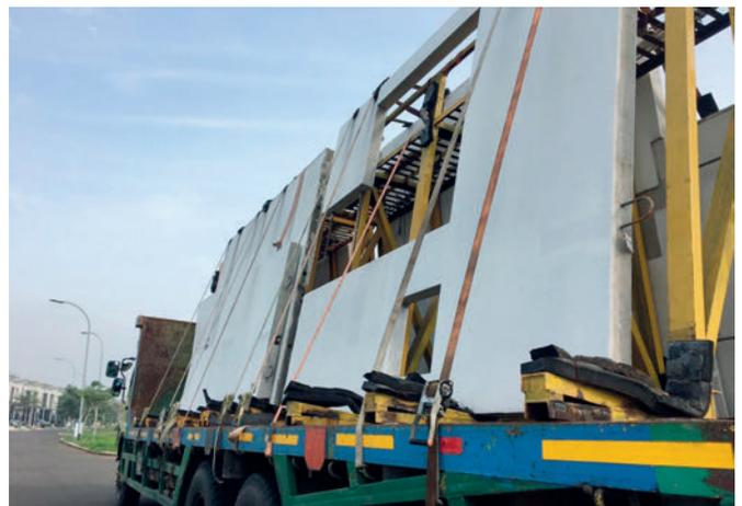
Die erdbebengeprüften und -sicheren Elemente mit den bereits vorgesehenen Aussparungen für Türen und Fenster werden zu den Baustellen transportiert.
