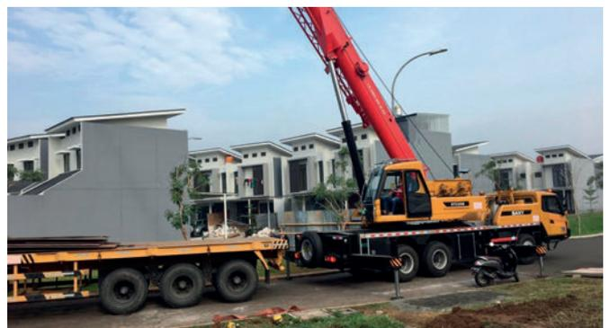
Die Bauzeit wird durch den Bau mit Fertigteilen, die vor Ort mit Kränen und qualifiziertem Personal montiert werden, enorm verkürzt.
