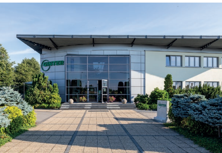
Siedziba firmy Ginter w Chojnicach.
