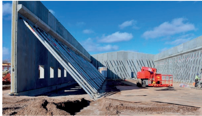
Budowę hali i montaż linii ukończono latem 2021 r.
