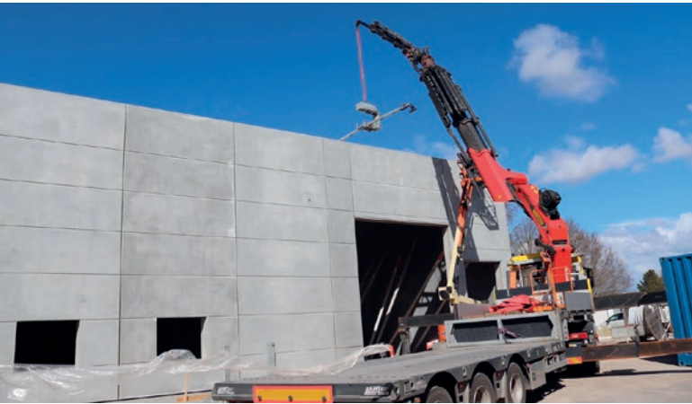
Nowa hala do produkcji zbrojenia, w której ustawiono linię zgrzewania siatek, została zbudowana z własnych prefabrykatów betonowych.
