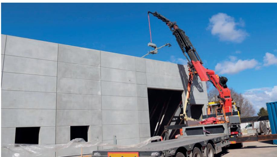
*Il nuovo capannone per la produzione dell'armatura per l'impianto di saldatura reti è stato costruito con propri prefabbricati in calcestruzzo.*
