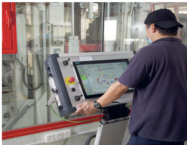
Come tutte le blocchiere dell'Hess Group, anche il nuovo impianto di Artic è dotato di un banco di comando.
