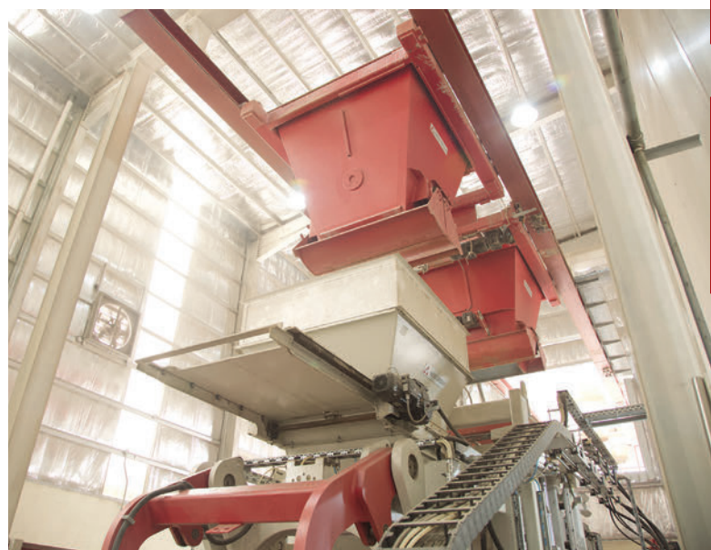
Il trasportatore a vagonetti doppio trasferisce il calcestruzzo per lo strato interno e il calcestruzzo di rivestimento nei silos di stoccaggio corrispondenti della blocciera.
