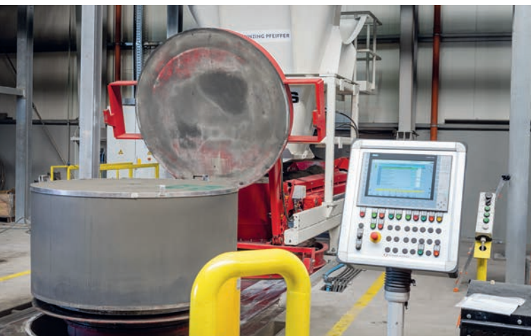
Le fond de regard frais (ébauche) après le décoffrage
