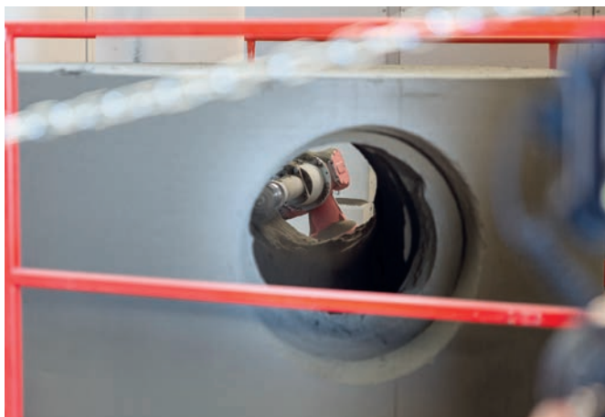
Fraisage du béton au millimètre près avec 2 têtes de fraisage différentes : à droite pour le canal et à gauche pour les entrées et les sorties
