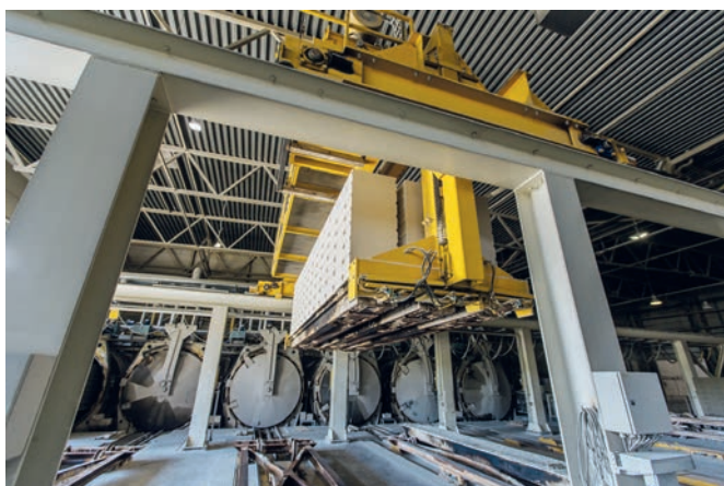
Impressions : la centrale à béton cellulaire Masa
