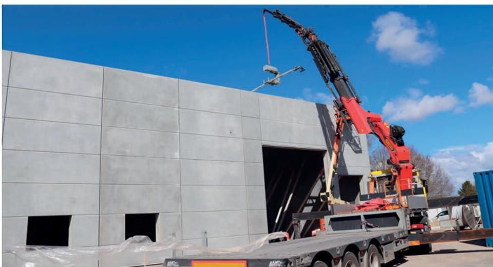
*La nueva nave de producción de armaduras para la instalación de soldadura de mallas se ha construido con prefabricados de hormigón de la propia empresa*
