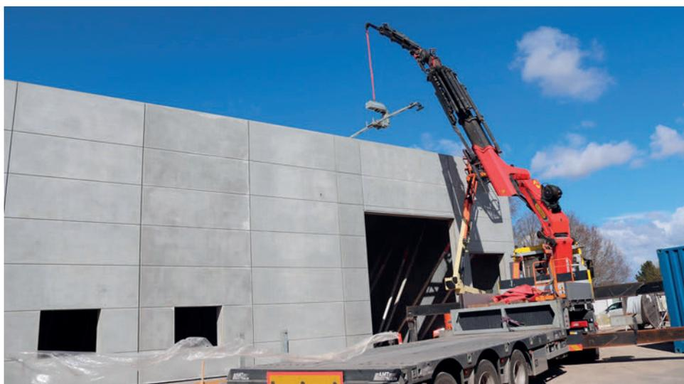
*Die neue Bewehrungsproduktionshalle für die Mattenschweißanlage wurde mit den eigenen Betonfertigteilen errichtet.*
