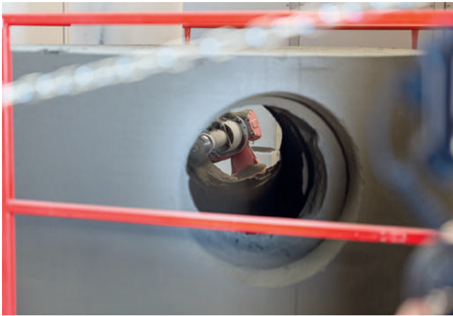
Millimetergenaues Betonfräsen mit 2 verschiedenen Fräsköpfen: rechts für das Gerinne und links für Ein- und Ausläufe
