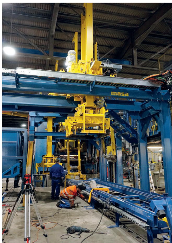
На этапе переоснащения: монтаж обратного транспортера, перестановщика слоев III и IV и станции кубирования
