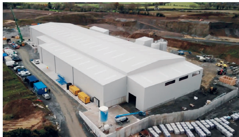
Завод Kilsaran Precast в Килкаллене, графство Килдэр, – это наиболее современный автоматизированный завод карусельного типа в Ирландии
