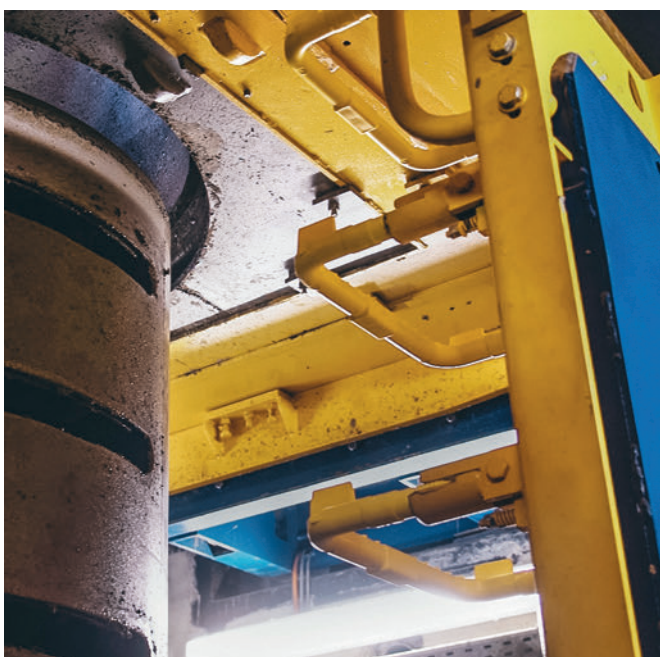
Les échelons - tout comme les ancrés de manutention - sont pris par la machine en automatique et directement scellés dans le béton frais.
