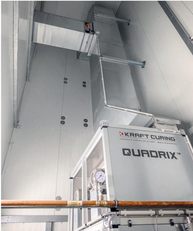
Un local technique aménagé spécialement pour le système de cure facilite l'accès à l'installation et les opérations de maintenance.
