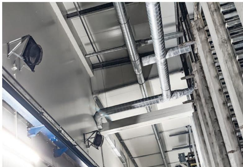
*Des conduites d'air situées à l'intérieur de la chambre maintiennent un climat idéal pour le durcissement des produits en béton.*
