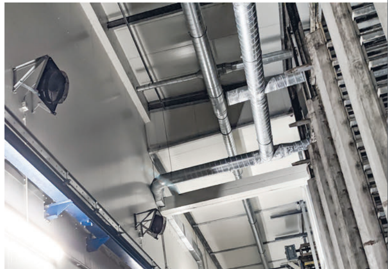
El pasillo de la plataforma de desplazamiento también se aisló, se montó la luz y la ventilación.
