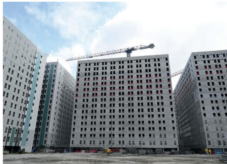
Construcción de viviendas asequibles de 14 plantas, fabricado en su 90 % con prefabricados
