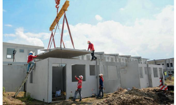
Los prefabricados utilizados son paredes macizas de 100 mm de espesor alrededor de las dos plantas, que cumplen los requisitos mínimos de las normas de la construcción. Las losas macizas de 120 mm se suministran en una sola pieza.
