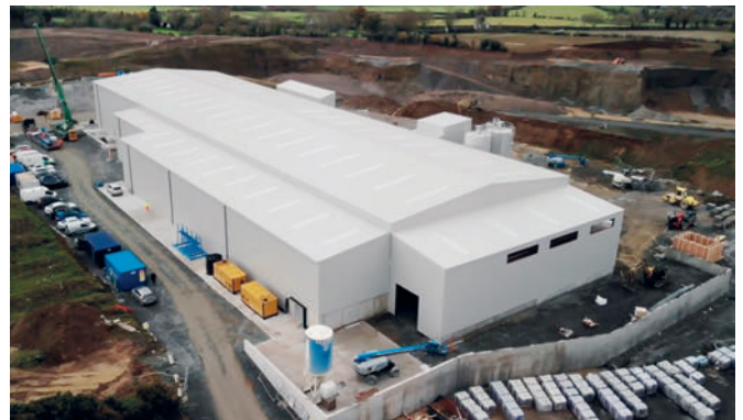
Kilsaran Precast en Kilcullen, condado de Kildare, cuenta con una de las instalaciones de circulación más modernas y altamente automatizadas de Irlanda.
