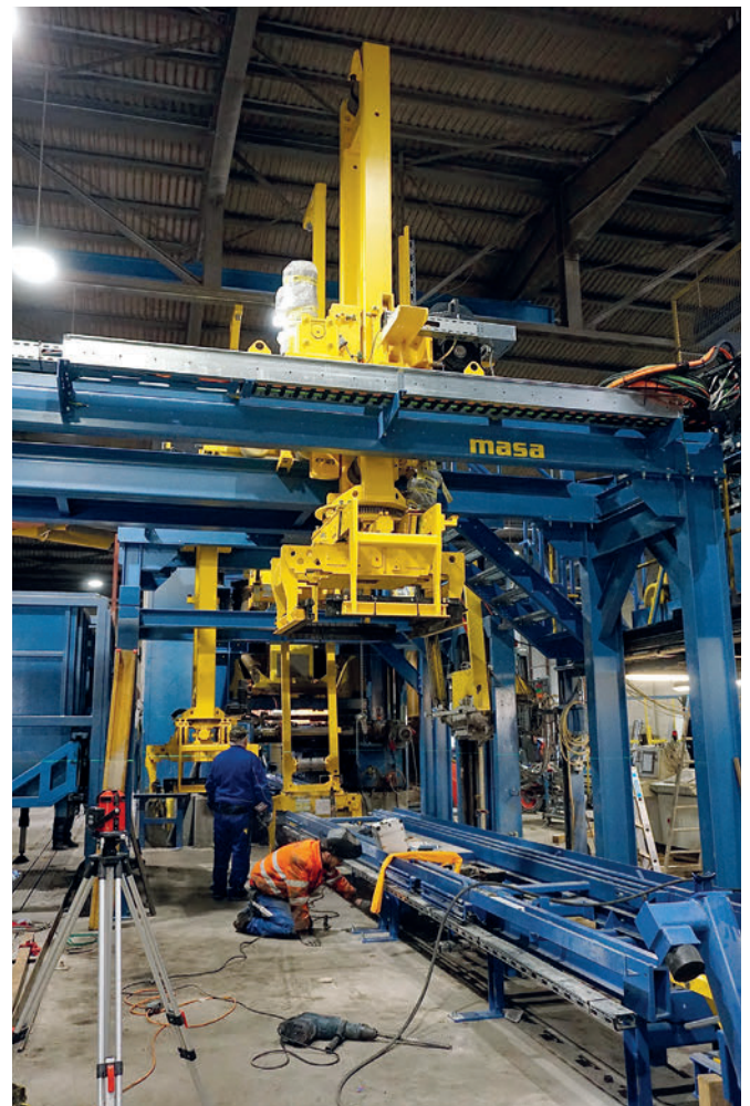
Während der Umbauphase: Montage von Rücktransport, Lagenumsetzer III und IV sowie Cuboter
