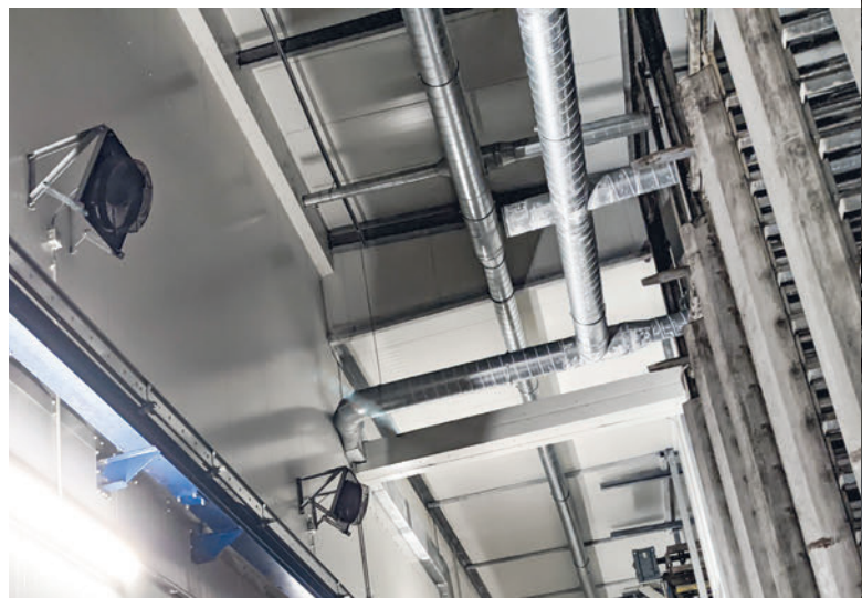
Innenliegende Kanäle sorgen für das richtige Klima innerhalb der Kammer.
