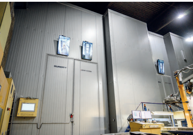
Hub- und Senkleiter sind ebenfalls komplett eingehaust.
