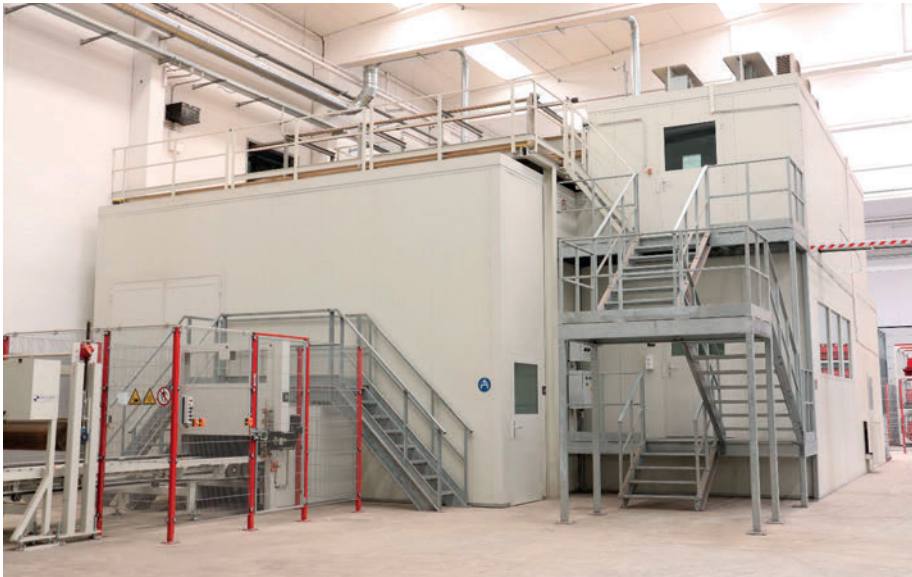
Maschinenschallschutz-, Kontroll- und Schalt- schrankraum
