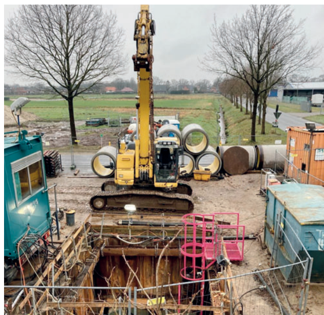
Типовой склад труб Perfect Pipe на строительной площадке (Харен, Германия). В 2021 году здесь впервые в Германии была выполнена проходка с укладкой труб для микротоннелирования Perfect Pipe DN 1200
