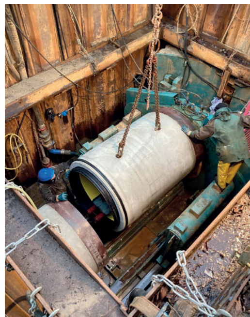
Как правило, пространство, доступное при тоннельной проходке, ограничено. Тем важнее преимущества трубопровода для микротоннелирования Perfect
