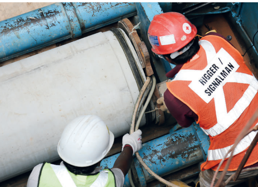
Укладка труб для микротоннелирования Perfect Pipe в первом проекте подобного рода в Сингапуре (см. выпуск журнала «Международное бетонное производство» 2/2016)
