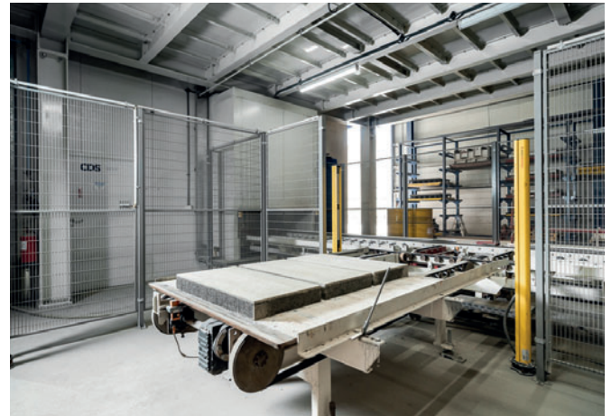
Станция контроля качества
