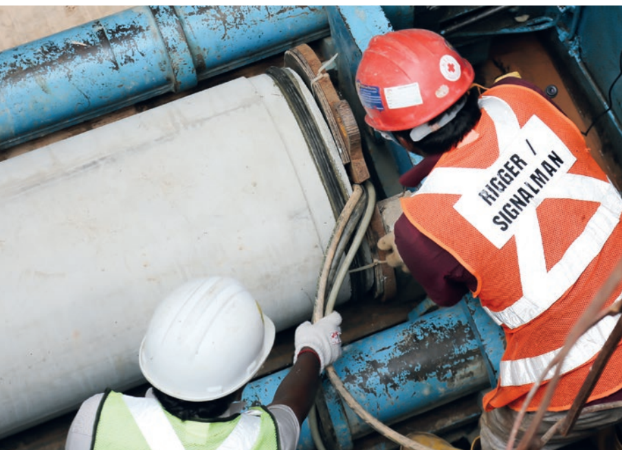
Montaż rur przeciskowych Perfect Pipe w pierwszym tego typu projekcie realizowanym w Singapurze - realizację opisano w ZBI 2/2016.
