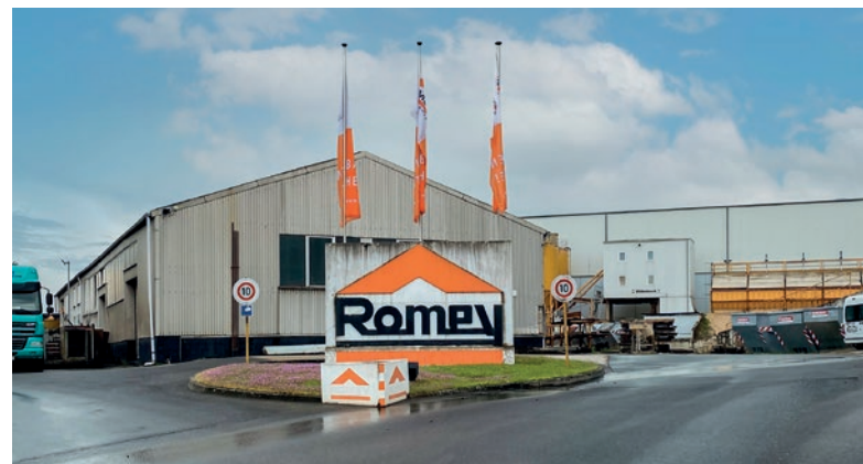
Siedziba firmy Romey Baustoffwerke w Plaidt, gdzie ponad 70 lat temu wszystko się zaczęło.
