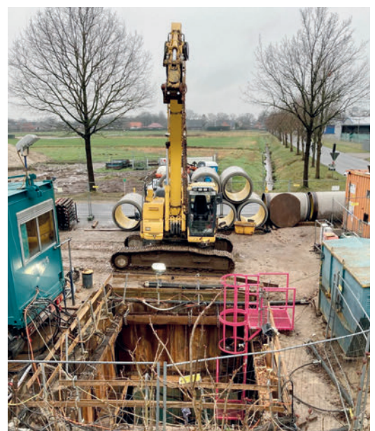
Tipico deposito di cantiere di Perfect Pipe (Haren, Germania). Nel 2021, per la prima volta in Germania, sono stati usati tubi di spinta Perfect Pipe con DN 1200.
