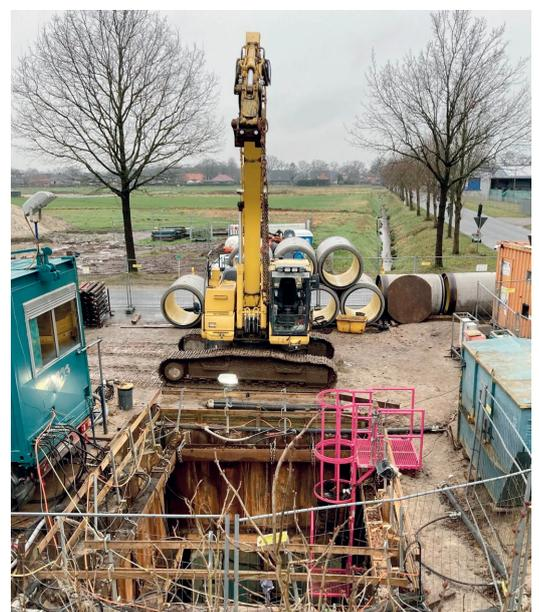
Entreposage typique de Tuyaux Perfect sur un chantier (Haren, Allemagne). Pour la première fois en Allemagne, des tuyaux de fonçage Perfect de diamètre nominal 1200 ont été posés sur ce chantier en 2021.
