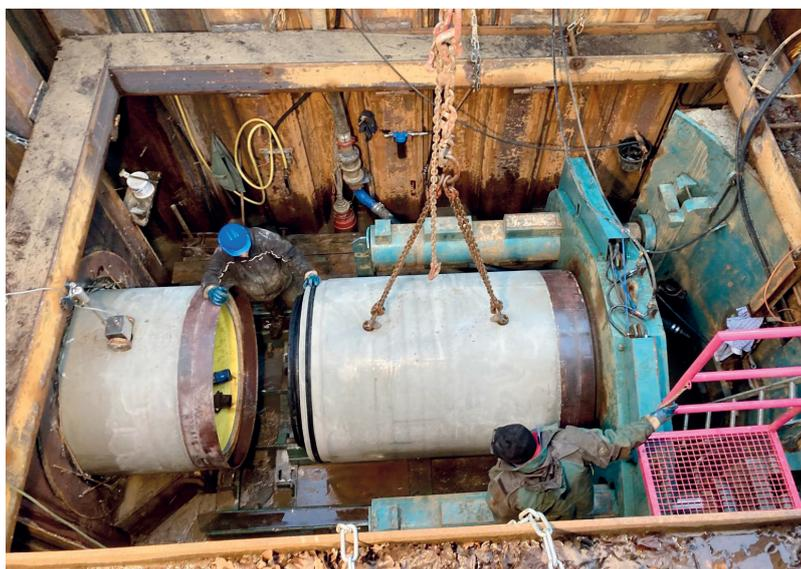
Le raccordement entre tuyaux de fonçage Perfect est réalisé au moyen de connecteurs plastique avec joints extérieurs. Ces connecteurs permettent à la fois une certaine flexibilité de l'emboîtement au cours de la pose et, d'autre part, évitent le recours à tout soudage ultérieur jusqu'à un diamètre de tuyau de 1500 mm.
