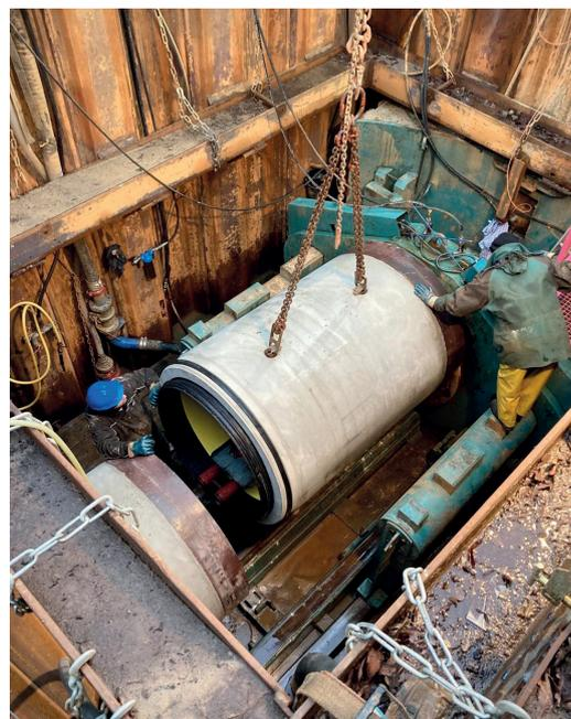
Les activités de fonçage se font généralement dans un espace restreint. Les avantages des tuyaux de fonçage Perfect prennent ici tout leur sens, le procédé permettant d'obtenir dès l'insertion du tuyau suivant un système de conduite complet et protégé contre la corrosion.
