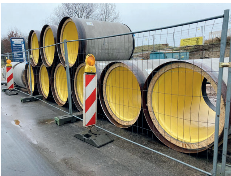
Típico almacén de Perfect Pipe en obra (Haren, Alemania). En 2021 se introdujeron a presión por vez primera en Alemania tubos para hincado Perfect Pipe con DN 1200.
